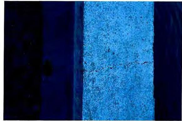
Fotografía N° 5: Ejemplo fisuras en viga de coronamiento, Conservación Aeródromo Caleta Tortel 2015.
