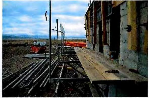
Fotografía N° 13: Andamios en volado Edificio SSEI en condiciones inseguras, Ampliación Área de Movimiento Aeródromo Balmaceda.
