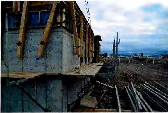
Fotografía N° 12: Andamios en volado Edificio SSEI en condiciones inseguras, Ampliación Área de Movimiento Aeródromo Balmaceda.
