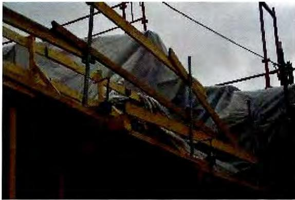
Fotografía N° 10: Andamio en volado en edificio DGAC, en condiciones inseguras, Ampliación Área de Movimiento Aeródromo Balmaceda.
