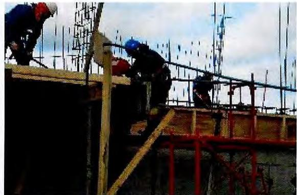
Fotografía N° 9: Mal uso de andamio. Ampliación Área de Movimiento Aeródromo Balmaceda.
