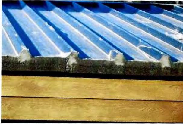
Fotografía N° 1: Falta de cortagotera, Reposición Refugio de Pasajeros Aeródromo Villa O'Higgins.
