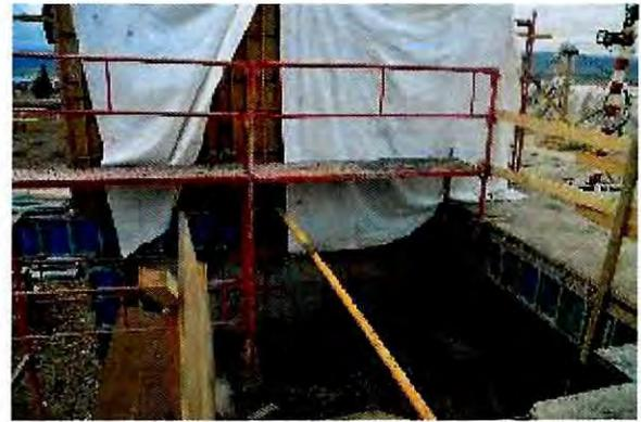
Fotografía N° 11: Andamio en edificio DGAC, sin rodapie, Ampliación Área de Movimiento Aeródromo Balmaceda.
