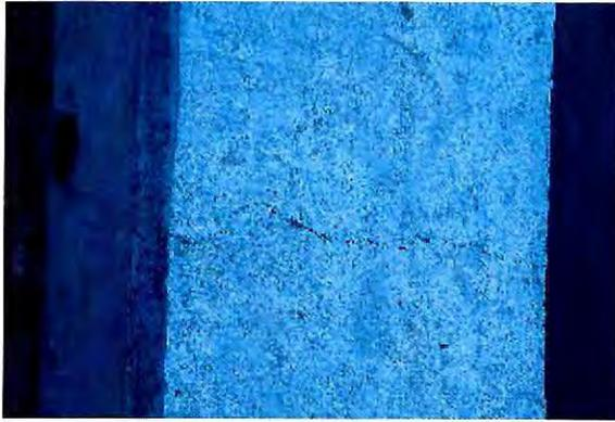
Fotografía N° 4: Ejemplo fisuras en viga de coronamiento, Conservación Aeródromo Caleta Tortel 2015.
